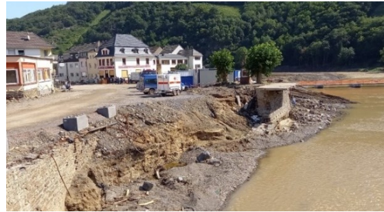
Ortsbild im Bereich der Gemeinde Rech im Herbst 2021
