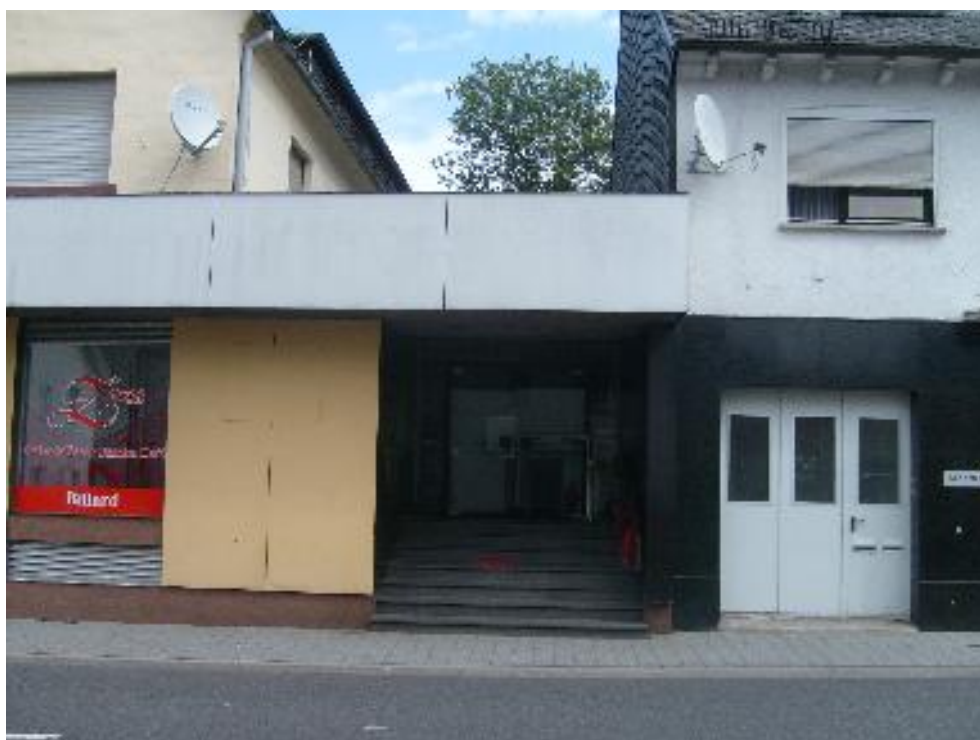
A.straße 1, Ansicht Südwest (23.08.2011)
