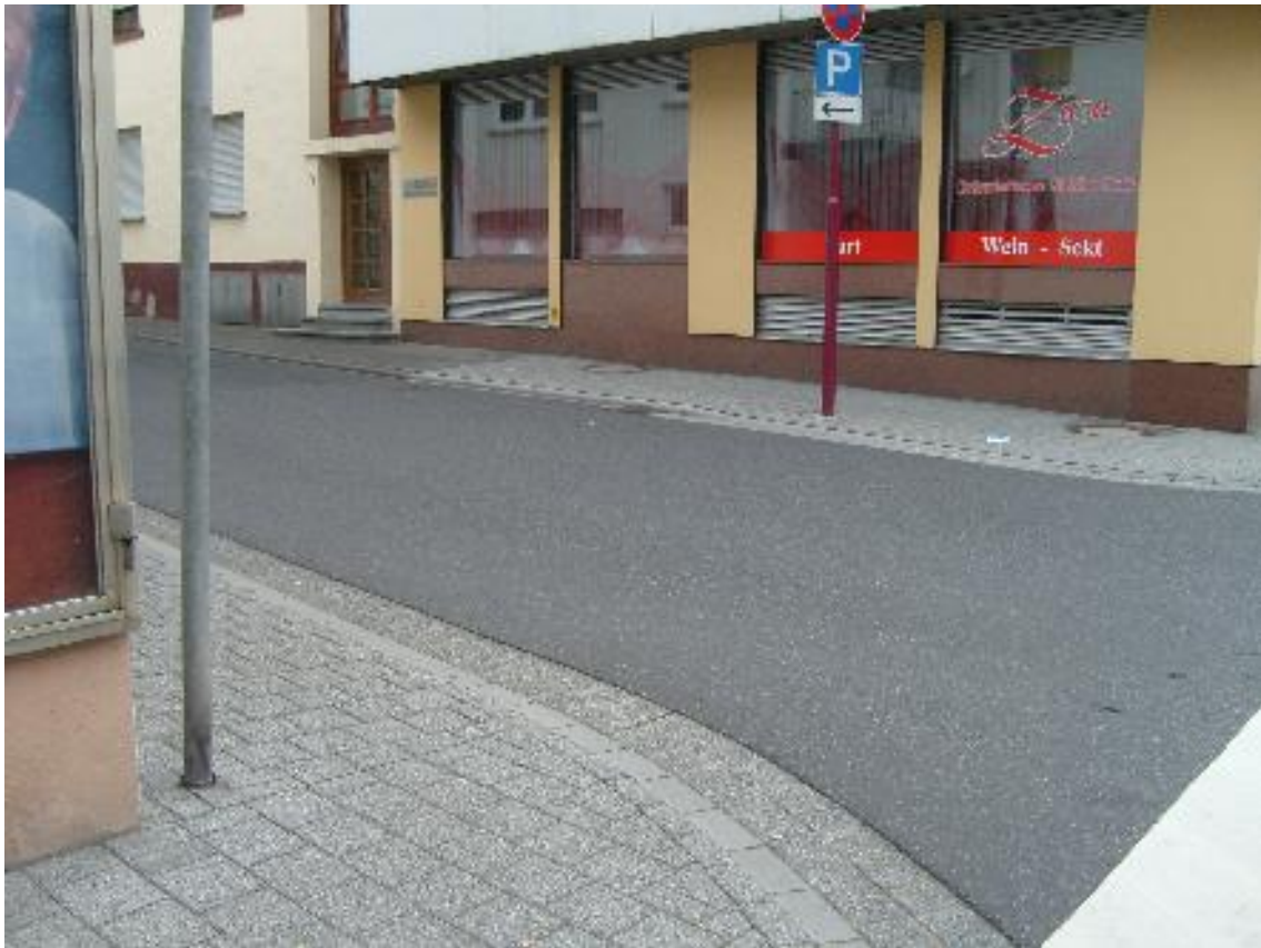
Einmündungsbereich S.gasse – A.straße (23.08.2011)
