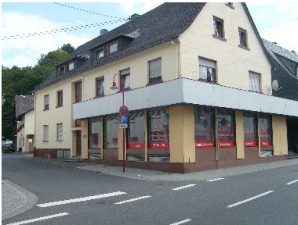
A.straße 1, Ansicht West (23.08.2011)
